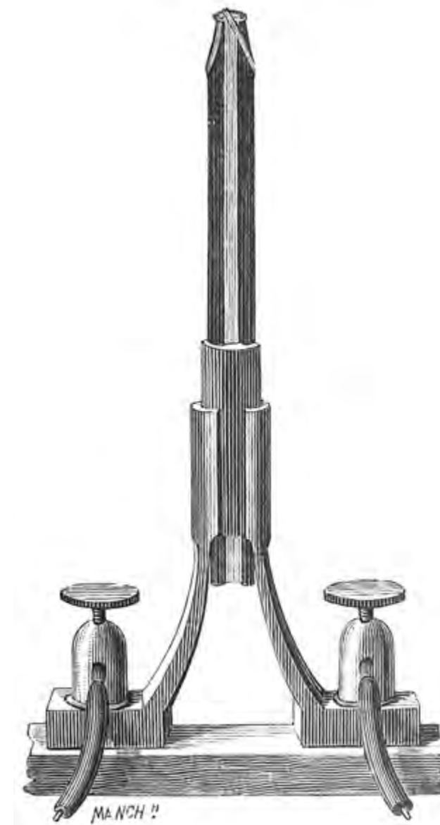
Figura 3: Bujía eléctrica de Jablochhoff. Esta bujía satisface completamente la condición de mantener constante la distancia entre los carbones sin regulador. Grabado tomado del libro [1], p. 727.
