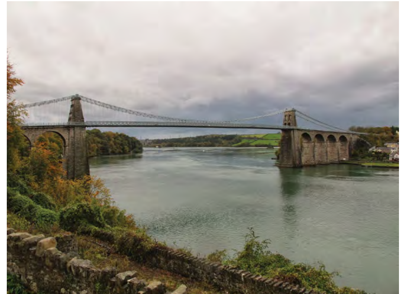
Figura 2.4: El puente colgante de Menai entre Gales y la isla de Anglesey permite atravesar el estrecho del mismo nombre. En esta vista panorámica se observa la estructura de piedra construida para estabilizar las torres sometidas a empujes horizontales debidos al viento. Fotografía obtenida del libro [6], pp. 28, 29.
