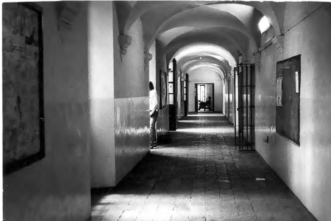
Figura 4.44: Fotografía de un pasillo de la zona del colegio Carolino conocida como “Las Catacumbas”, en la década de 1950.
