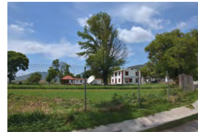
Figura 4.30: Vista exterior de la central hidroeléctrica de Portezuelo, Atlixco, Puebla.
