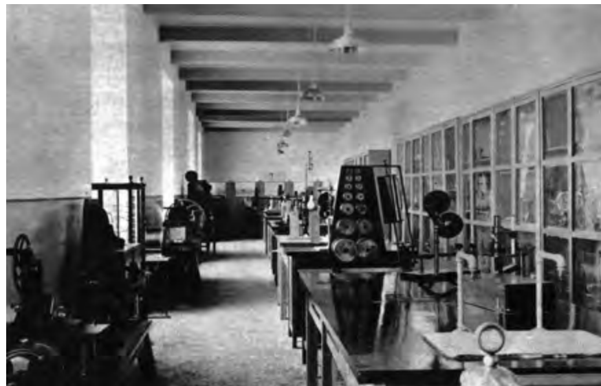
Figura 4.20: Gabinete de Física. En primer plano puede observarse el aparato de Koenig para el análisis del sonido (ver fotografía actual del aparato en el Museo Universitario, fig. 8.29).
