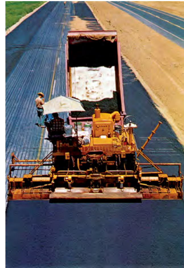
Figura 4.39: Máquina moderna para el tendido de carpeta asfáltica.
