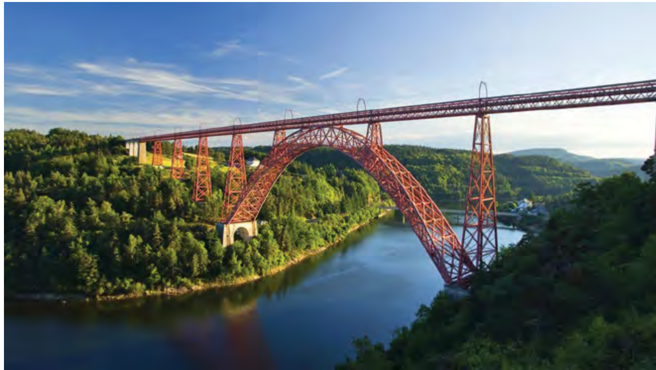
Figura 2.5: Viaducto Garabit en las montañas de Auvergne en la Francia central. Fue completado en 1885 y por mucho tiempo fue el más alto del mundo, elevándose 124 m sobre el río Truyère. Construido con armaduras de hierro por Gustav Eiffel y Maurice Koechlin. Fotografía del libro [5], p. 157.
